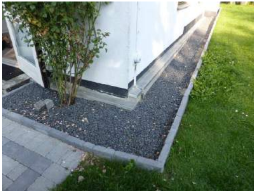
Sydvestligt hjørne med efterisolering i kælderen.
